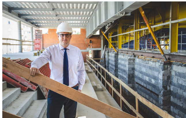
Jakub Gręziak Zastępca Burmistrza Dzielnicy Bemowo na terenie budowanej hali
